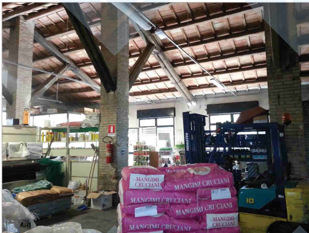
corpo fabbrica fronte strada – pilastri e struttura tetto in legno
