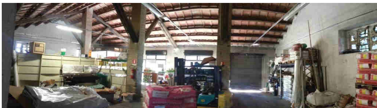
corpo fabbrica fronte strada - vista interna
