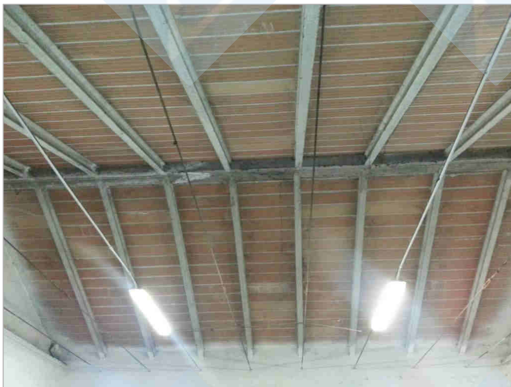
corpo fabbrica posteriore – struttura tetto in travetti precompresso
