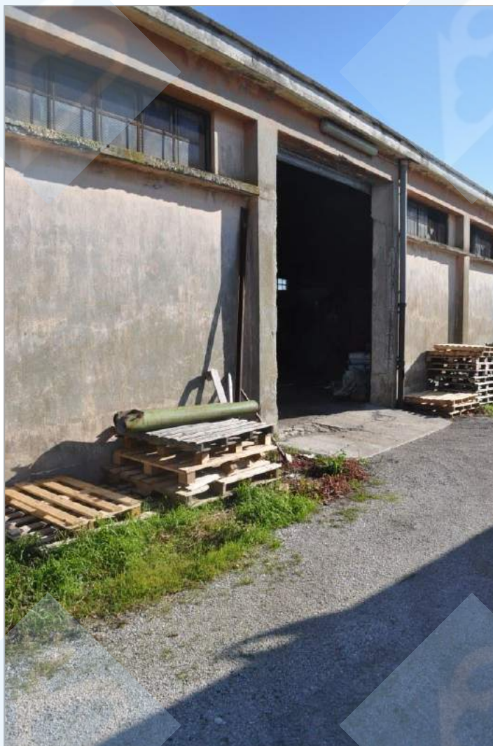
prospetto ovest accesso al magazzino
